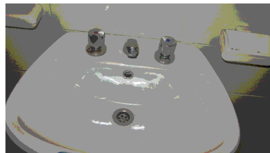
FOTO 1 Lavandino bagno esistente
